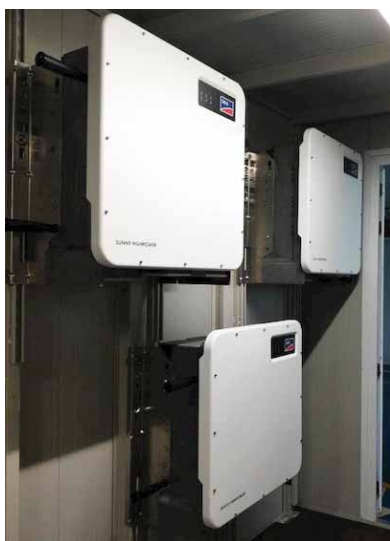
Nell'immagine, gli inverter centralizzati SMA
