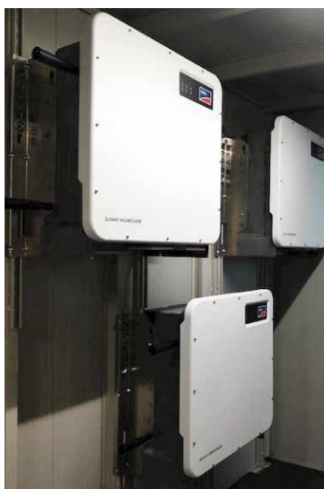
Nell'immagine, gli inverter centralizzati SMA
