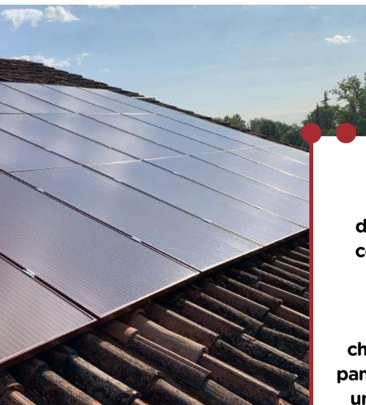
**Gli impianti sono dotati di telecontatori con programmi di gestione da remoto. Ciò significa che sotto ad ogni pannello è presente un ottimizzatore**
