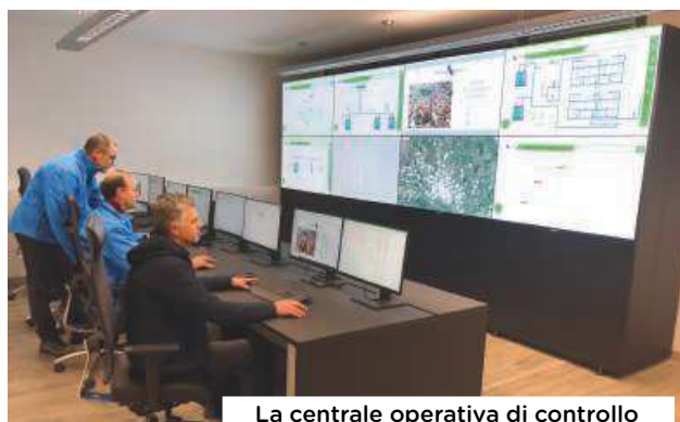
La centrale operativa di controllo
